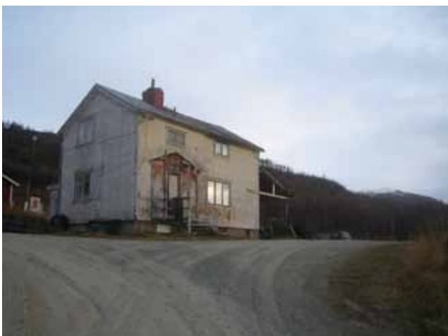
Den gamla gårdbyggnaden finns kvar men är i dåligt skick
