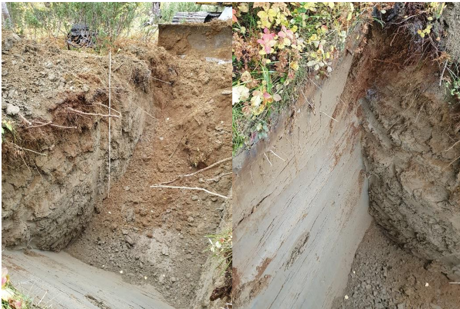
Figur 12. Foto tagit i provgrop 5, jorden bestod främst av silt.
