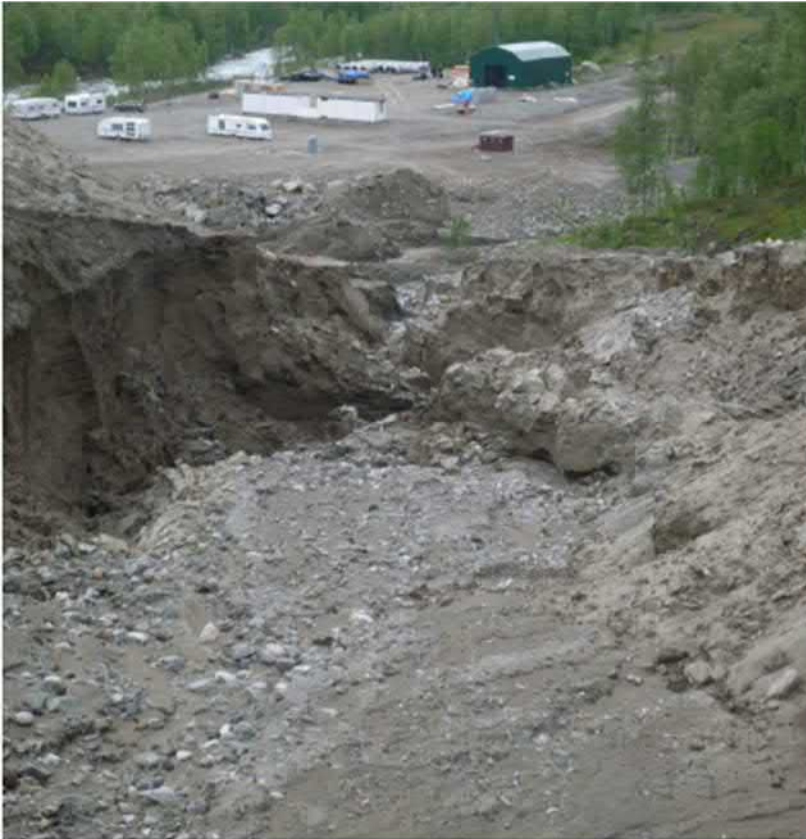
Figur 10. Kraftig erosion i planerad ny pist.
