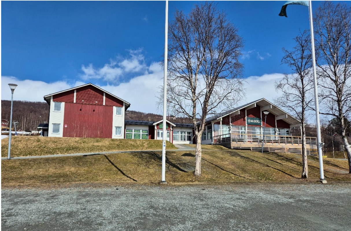
Befintlig byggnad "centrumhuset" inom Björkfors 1:594.
