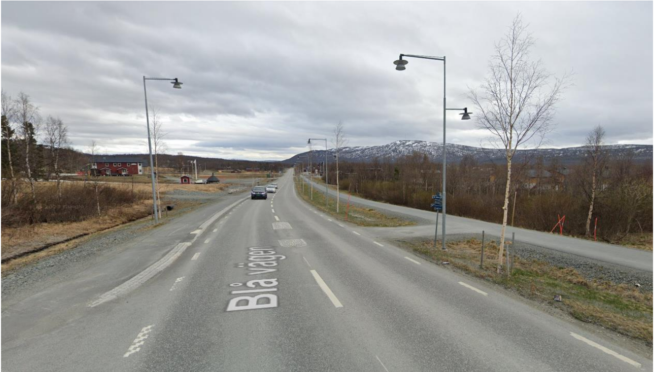
Bild 3. Foto över gångpassage över väg E12 Blå vägen vid Fjällstigen. (Google Maps)
