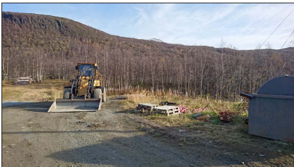
Till höger om traktorn i bilden är ungefärlig byggplats.
