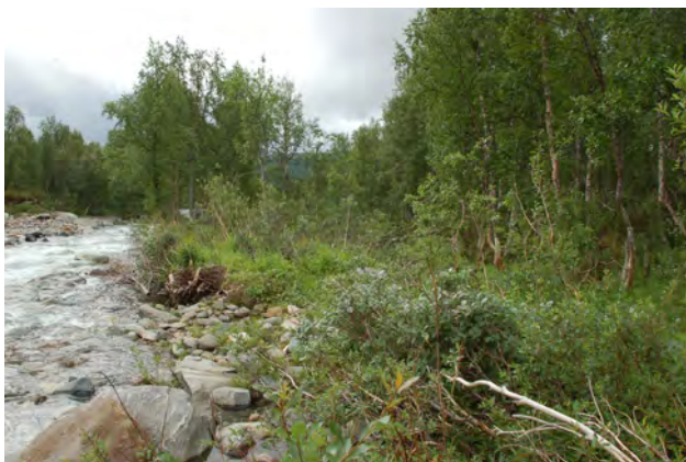
Bild 3.7. Översvämningsspår vid bäckloppet i nedre delen av aktuellt område
