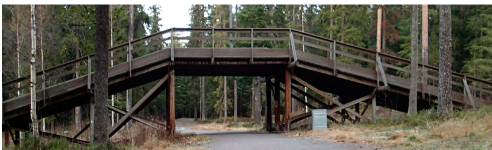
Exempel på skidbro av trä. Med markfyll på ömse sidor blir bron mindre och nättare.
